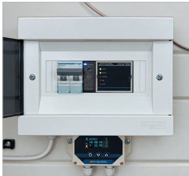
Рис. 2. Точка контролю вологості та температури
