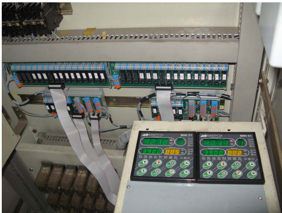
Рис. 2. Монтаж контроллеров МИК-51 в щите управления АПО газа
