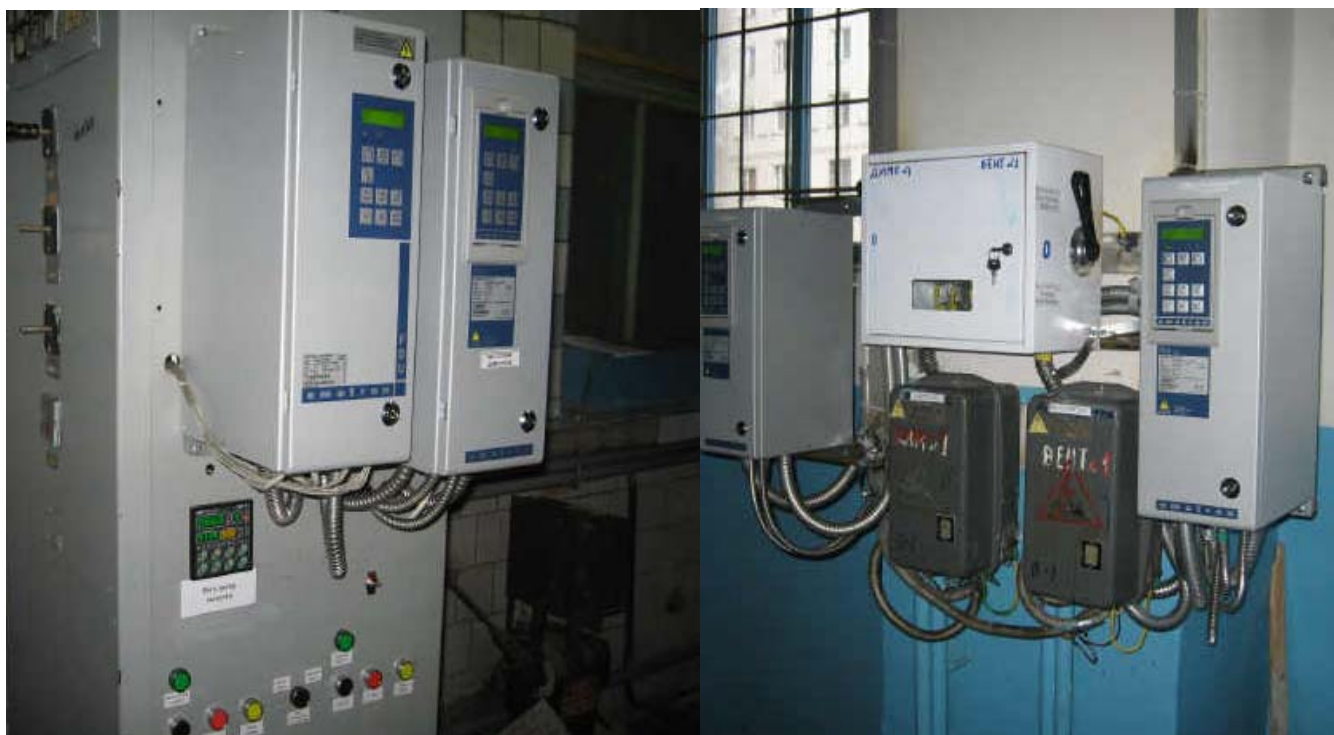
Рис.3 – АСУТП котельного агрегата
